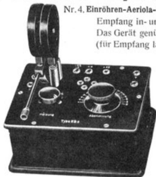
Nr. 4. Einröhren-Aeriola-Empfänger für alle Wellen. An Hochantenne Empfang in- und ausländischer Stationen im Kopfhörer. Das Gerät genügt auch für Empfang an Zimmerantenne (für Empfang langer Wellen 2 Spulen 100—250 W mehr) *RM* 27,—
